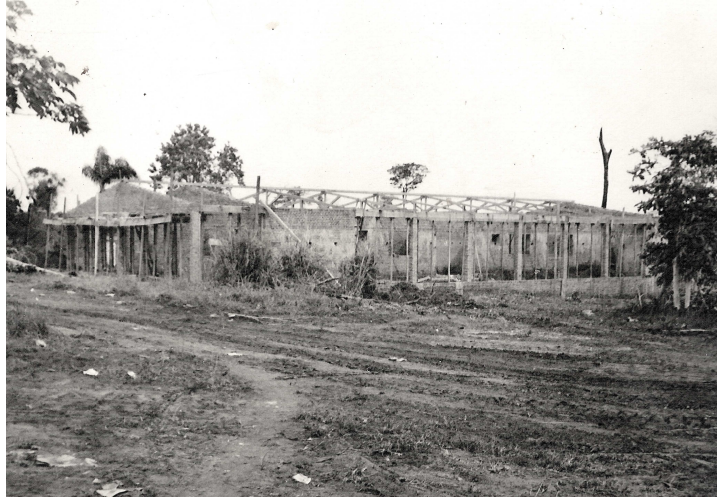
Klinikken under oppføring
